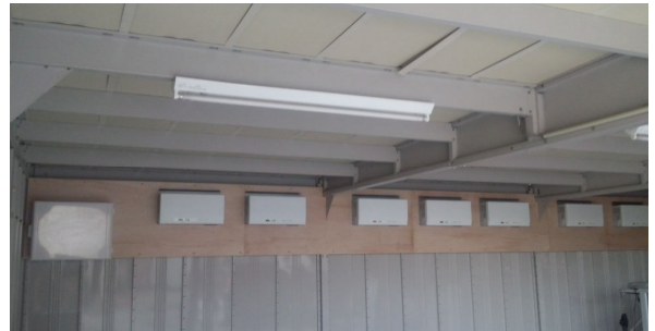
三河オフィスに設置されたパワコン
